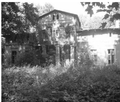
Fot. 13. Dwór w Równiej – pustostan fot. A. Kubiak (2006)
