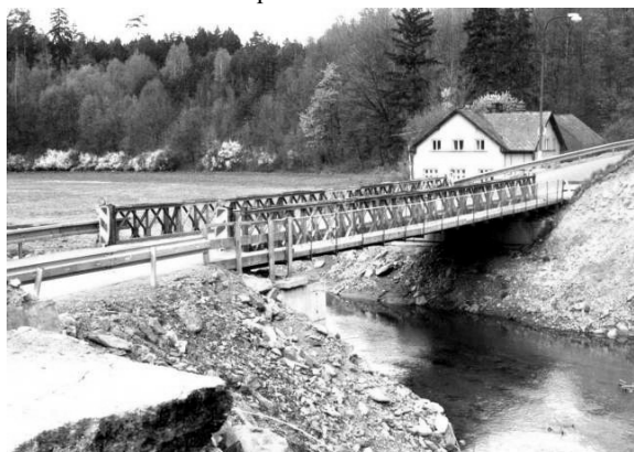
Obr. provizorní most BB
