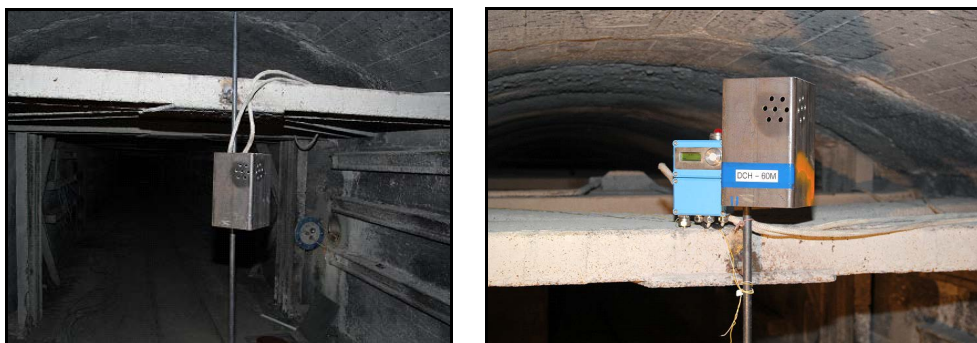
Rys. 3. Sposób montażu czujników metanu
