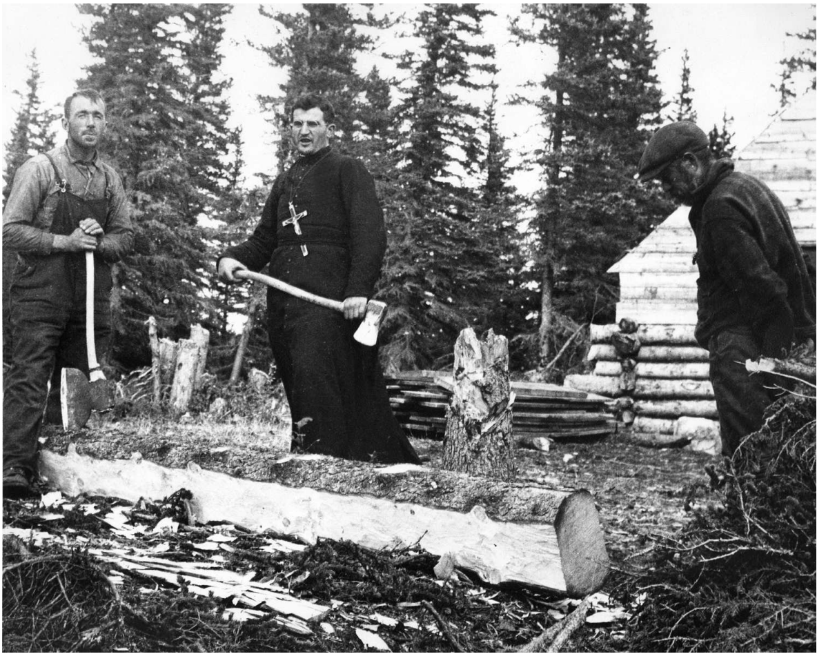
Vieux Comptoir – budowa misji, wrzesień 1937
