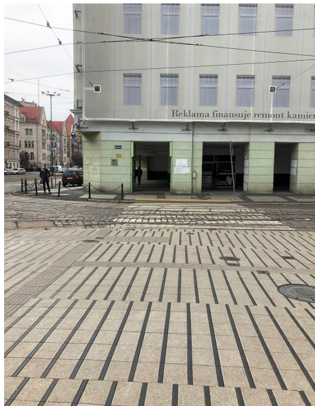
Ryc. 6. Nieodpowiednie przejście dla pieszych na zrewitalizowanej części ulicy św. Marcin
