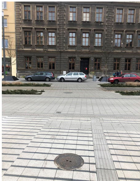
Ryc. 7. Nieodpowiednie przejście dla pieszych na zrewitalizowanej części ulicy św. Marcin
