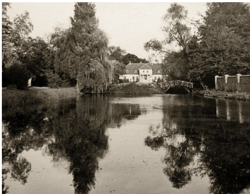
Ryc. 10. Park w Lututowie, widok na dwór od strony stawu zachodniego
