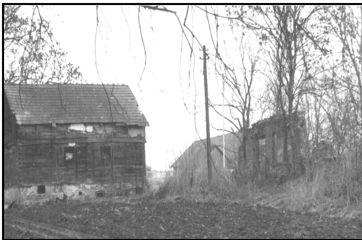
Fot.3. Budynek niszczonego spichlerza (po lewej, ruiny dworu (po prawej) oraz nowy budynek gospodarczy (w głębi)
