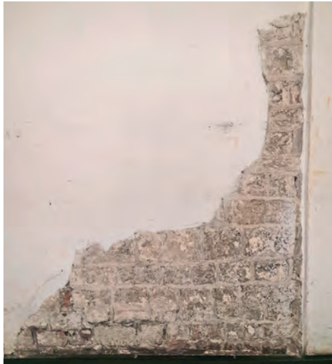
6. Kraków, katedra, relikw kamiennej przypory we wschodniej ścianie dawnej kaplicy św. Mikołaja, fot. Jakub Adamski
