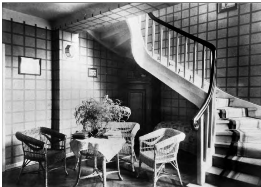
8. | Łódź, Kolonia Towarzystwa Budowy Domów dla Pracowników Zarządu Miejskiego, zdjęcie hallu nieustalonego domu kolonii, fot. ok. 1935 r., album w zbiorach prywatnych
