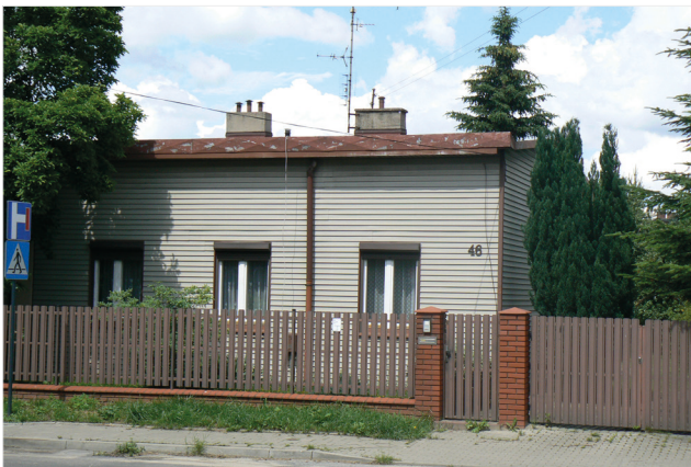
Fotografia 14. Ulica Czechosłowacka 46 Źródło: M. Rejter (2020)
