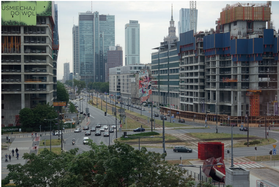
Ryc. 2. Ciągłe zagęszczanie wysokiej zabudowy biurowej, mieszkaniowej i usługowej zamienia ulice dużych miast w miejskie kaniony, całkowicie pozbawione zieleni; Warszawa, Wola, widok ul. Prostej w kier. Ronda Daszyńskiego
