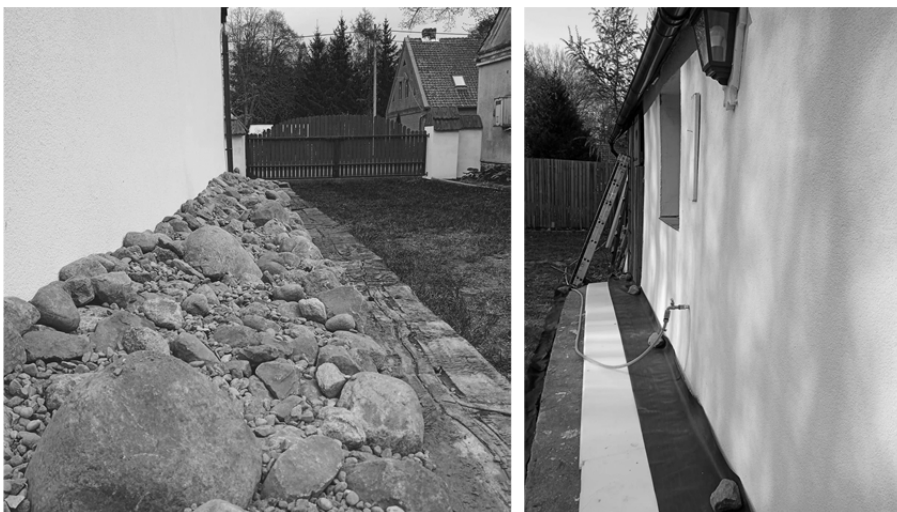
Zdjęcie 8, 9. Docieplenie na poziomie fundamentów
