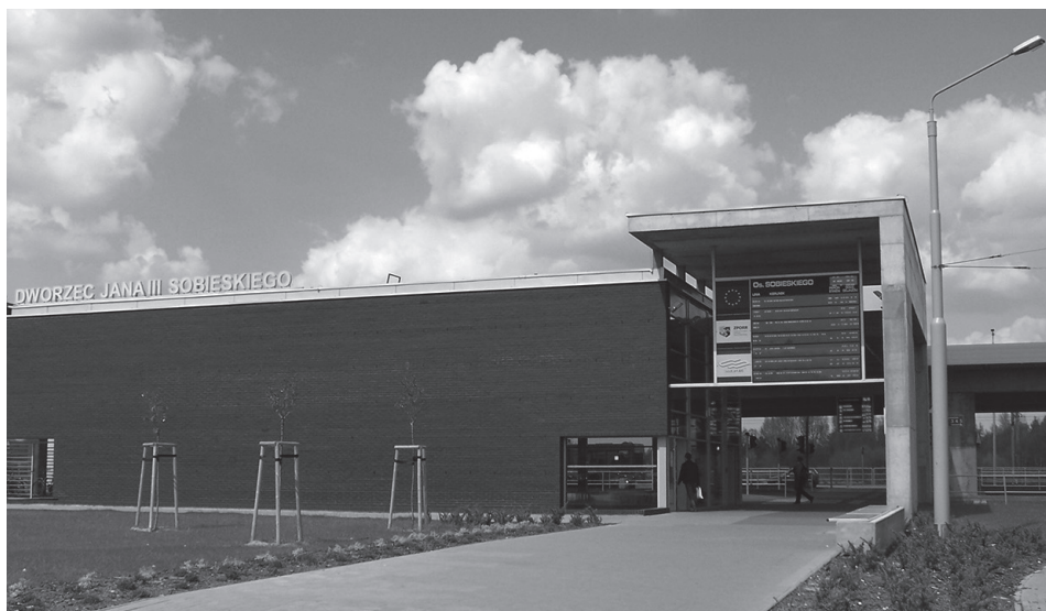
Fot. 2. Dworzec miejski na os. Jana III Sobieskiego
