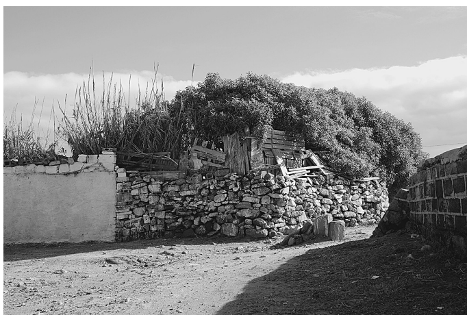
Fot. 2. Tradycyjny mur bez dodatku zaprawy, bidonville w El Hank
