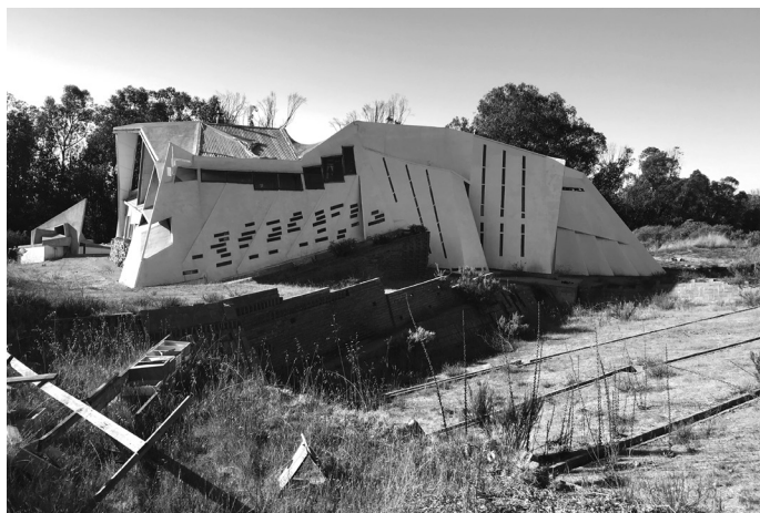
Fot. 4. Pracownia (Hospedería del taller de obras) w Mieście Otwartym.
