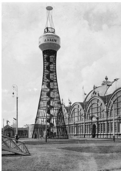
Ryc. 8. Wieża ciśnień projektu Szuchowa (z 1896 r.) w Niżnym Nowgorodzie. © Fot. M.P. Dmitriev (1858–1948). Dostęp online (5.07.2018), domena publiczna
