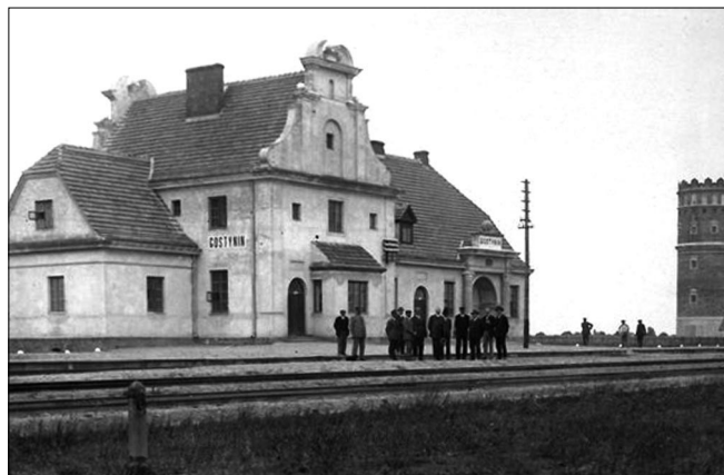
Budynek dworca w Gostyninie. W głębi wieża ciśnień. Zdjęcie ze zbiorów Muzeum Kolejnictwa w Warszawie
