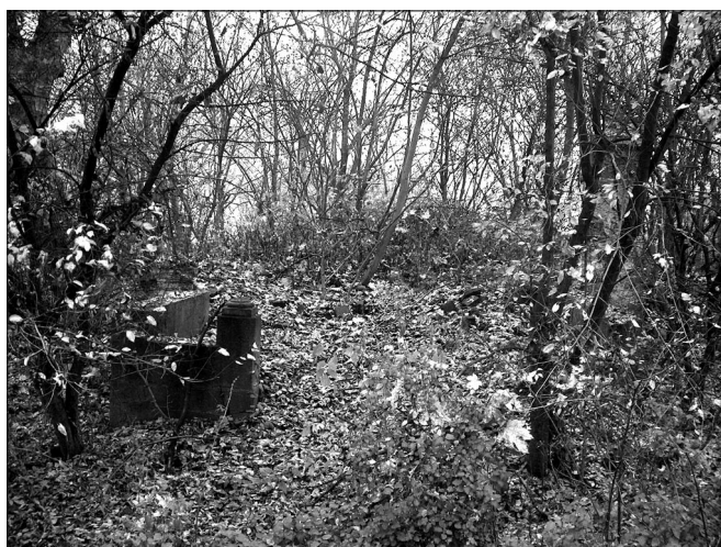
Fot. 19. Pozostałości starej części dworu w Grodkowie od strony ganku, stan obecny. Fot. B. Dziewanowski-Stefańczyk
