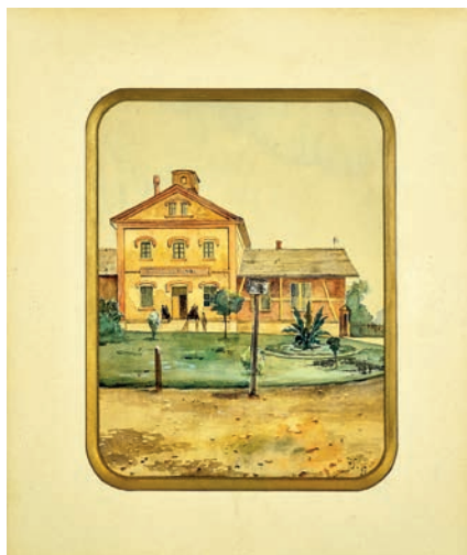
Fot. 11. Budynek szybowy z 1895 r., mal. H. Uziembło, 1897 r.
