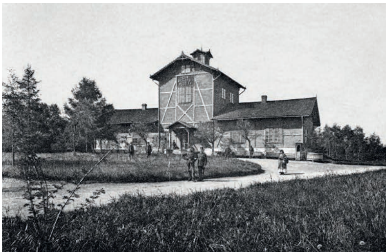
Fot. 8. Budynek szybowy w konstrukcji szachulcowej z 1879 r., fot. A. Szubert, 1892 r.
