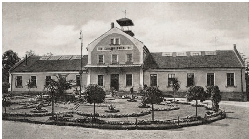
Fot. 12. Widok budynku szybowego, fot. W. Gargul, 1922 r.
