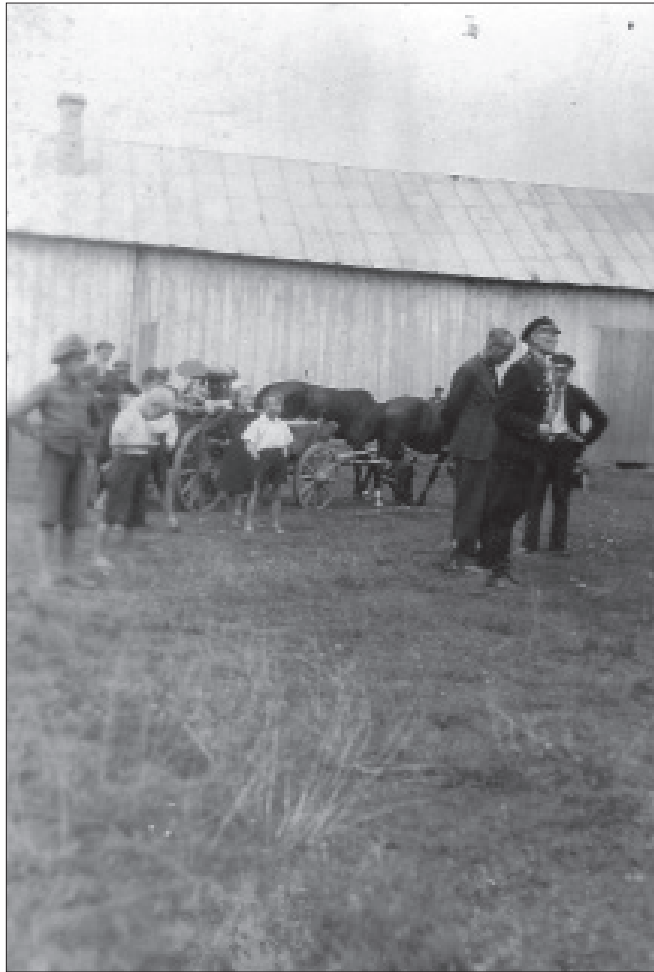
Budynek drewnianej remizy strażackiej w Niedzwicy Dużej, lata 30. XX wieku, fot. z archiwum rodzinnego Agnieszki Sienko
