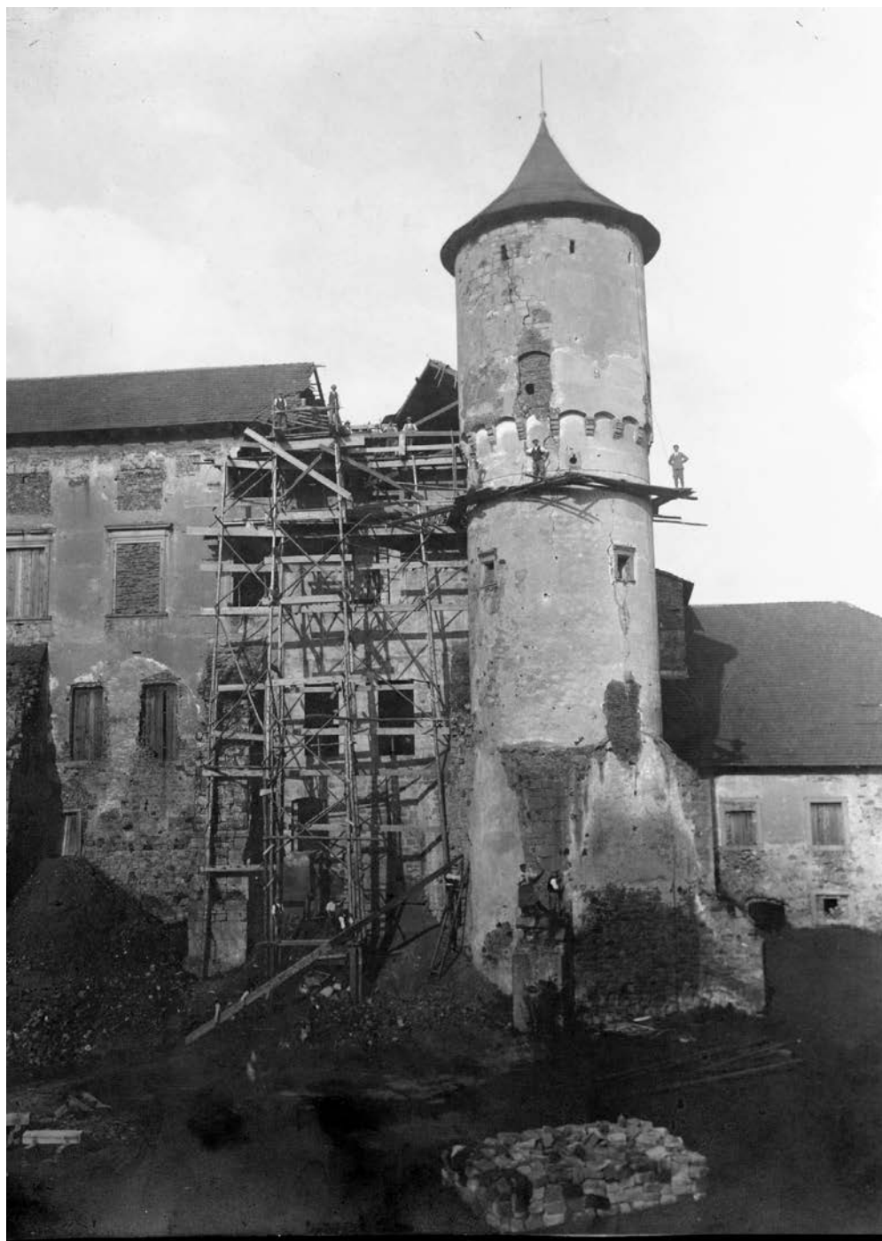
Odbudowa zawałonej części ściany zamku w Nowym Wiśniczu, lipiec–sierpień 1927 r. (AGAD, Archiwum Lubomirskich z Małej Wsi, sygn. 1552)
